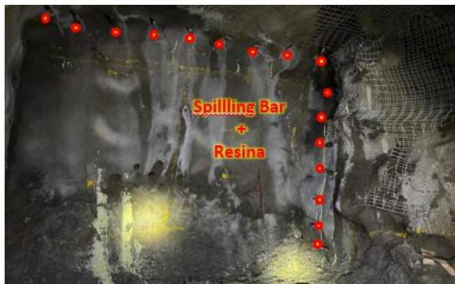
Figura 15: Resultados de Aplicación de Resinas Impermeabilizantes
